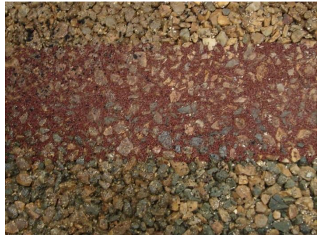
車道舗装材のサンプル確認
