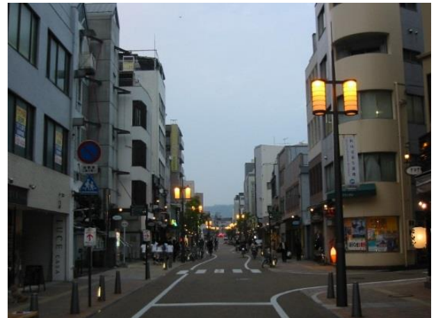
点灯時の道路照明
