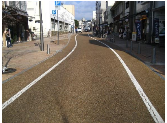
車道舗装の様子
