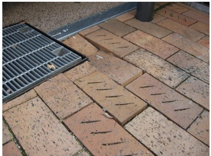
歩道舗装の破損状況の確認
