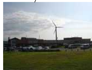
道の駅「能生(マリンドーム能生)」
