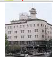
三菱倉庫(株) 本社 (その他歴史的建造物)
