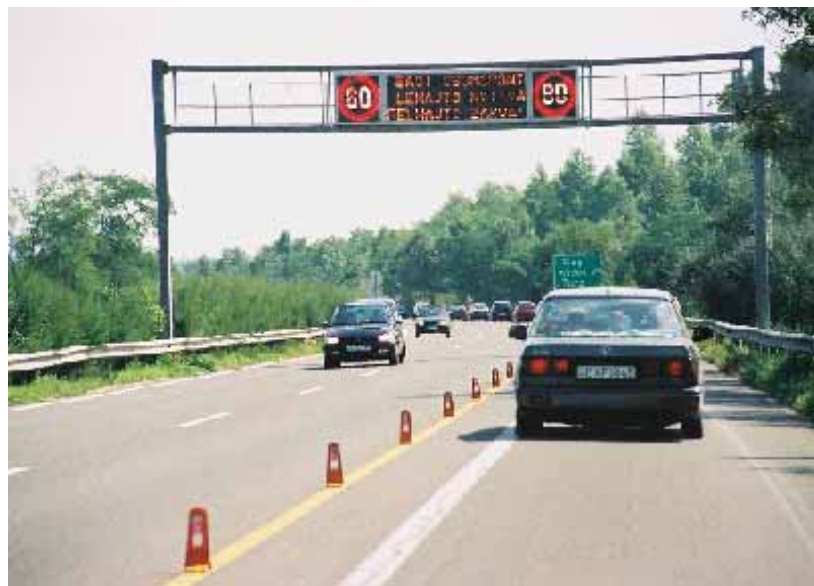
ハンガリーにおける路側帯を利用した車線数確保の例
