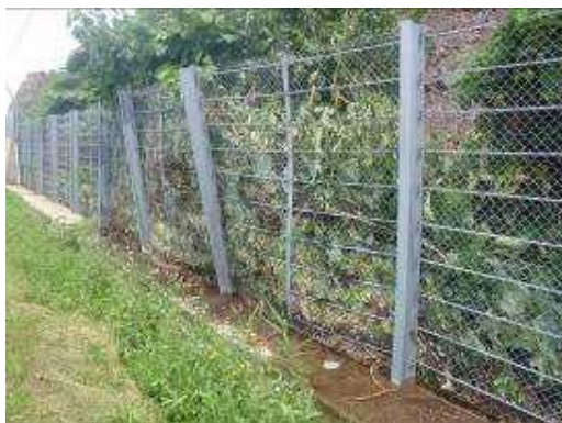
写真 落石防護柵の傾動の例
