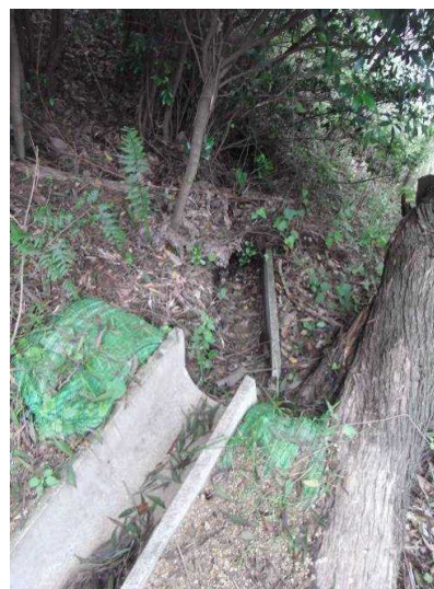
写真 排水溝の破損の例
