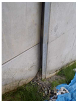
写真 土砂のこぼれ出し例
