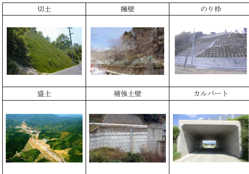
図－7 道路土工構造物を構成する施設の例
