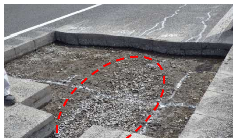
路盤の損傷の例 (路盤の細粒分がポンピングにより流失し、碎石が集まっている状況)
