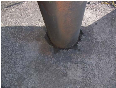
腐食、路面付近での滞水
