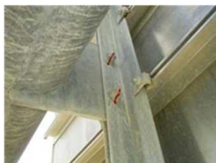
標識板取付部
