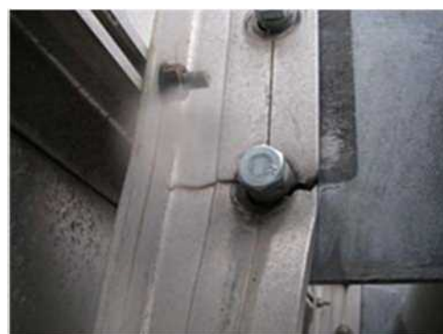
取付部の変状状況
