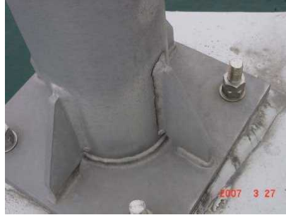
標識柱基部溶接部の亀裂
