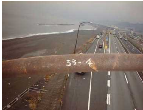
写真-解 8-11 支柱本体の腐食事例
