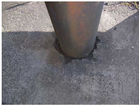
腐食、路面付近での滞水
