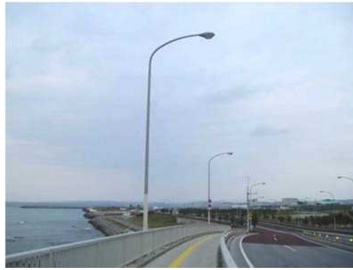
海岸付近に設置
