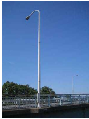
橋梁部に設置
