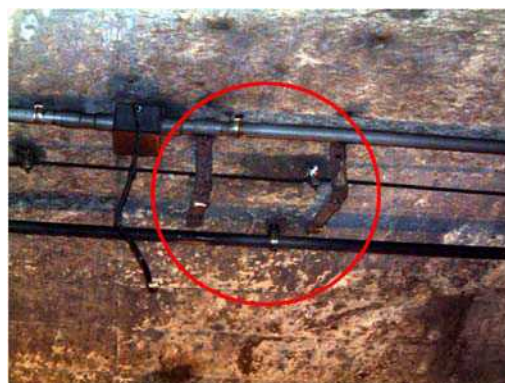
落下照明取付部の状況
