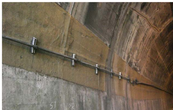
付写真-1.4.7 繊維シートの接着の例
