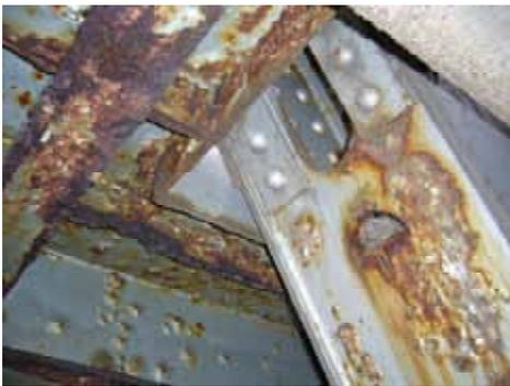
コンクリート橋外壁には、遊離石灰を伴うひび割れや内部鉄骨構造が腐食したための考えられる赤さび様の液体がコンクリートひび割れ部から多数露出している事が分かる。土木専門家の久田教授によれば、これはグラウトの充填不良によって形成された空隙に浸潤した水あるいは融雪剤成分による腐食であろうとの見解である。同じく現役鋼橋の腐食調査を行った。鋼橋は、典型的な橋梁用防錆塗装がなされているが、永年の侵食により塗膜面下の鋼材が腐食し、著しくは腐食孔にまで
