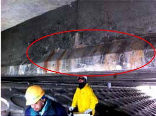
検査対象となるコンクリート中の鉄腐食状態が、実際にはどの程度のものを把握するために、土木専門家の共同研究者久田教授と討論し、いくつかの具体的な現役コンクリート橋及び鋼橋の腐食状態を調査した。いずれも現役橋梁であるので、腐食部から試験体を採取することは出来ないが、その調査結果を元に、検査対象とすべき鉄さびの程度を把握する事が出来た。
