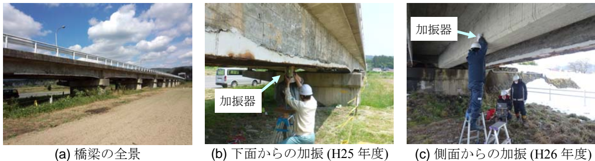
図-5.1 鋼板補強した道路橋 RC 主桁の現場試験
