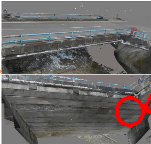
SfMによる橋梁3次元モデリング
