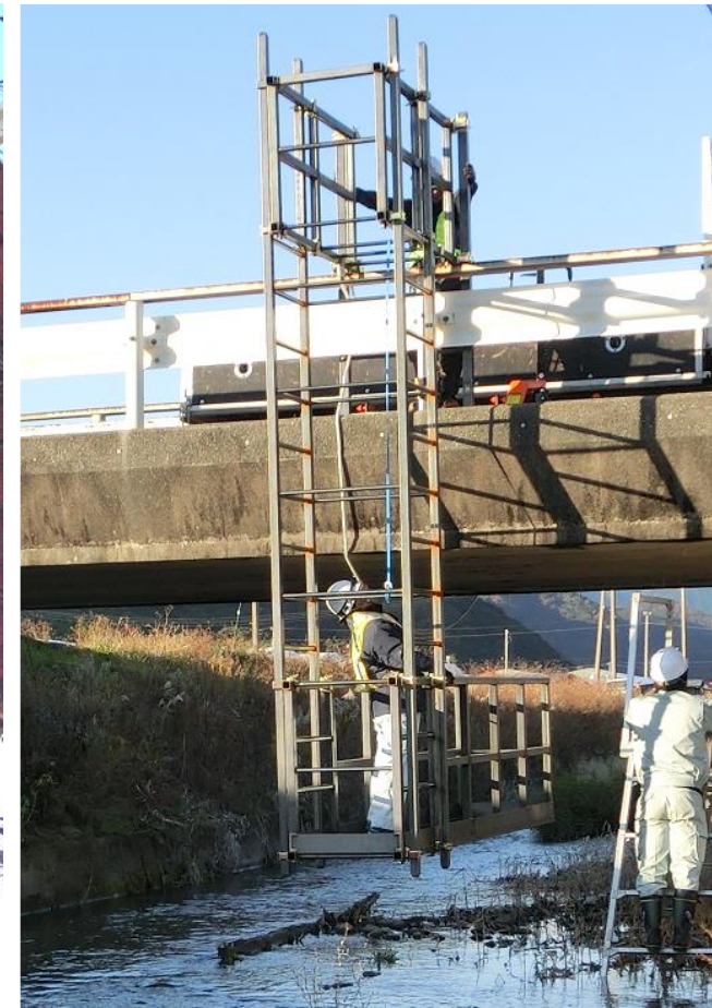
実橋検証状況
