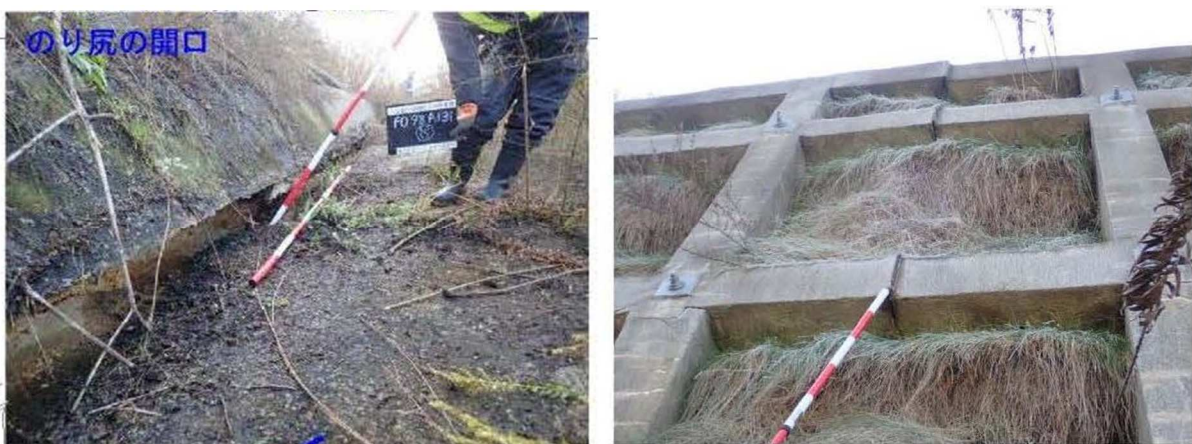
図 6.3.3-5 法枠の変状
