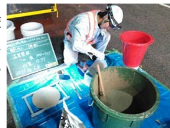
現道の空洞充填の試行
