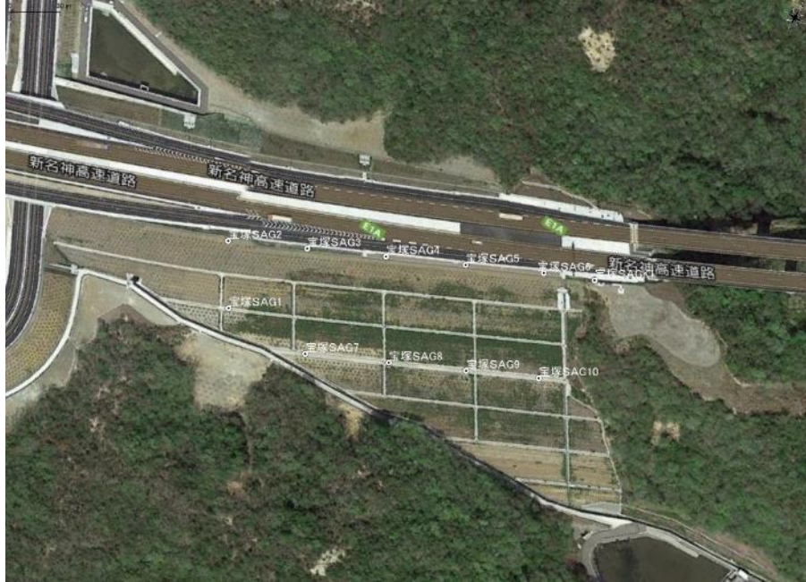
図 6. 3. 4-5 宝塚北 SA における盛土のり面への GNSS の配置
