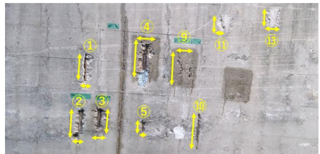
図 3. 打音検査（うき・剥離の寸法）
