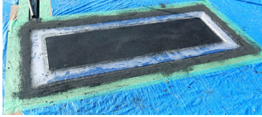
図 66. 円形走行路 表層コイル設置状況
