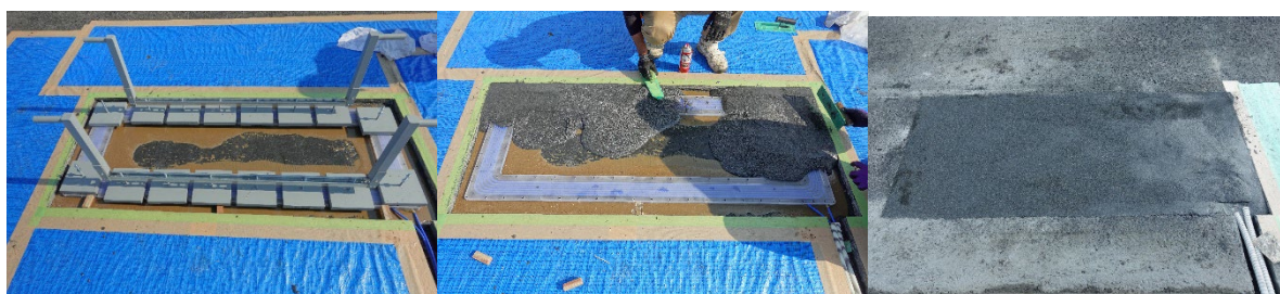
(d)コイルと接着剤の接着 (e)コイル上面樹脂施工 (f)中間層埋設後
