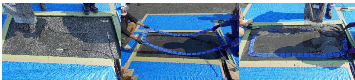
(a)コイル下面樹脂施工 (b)コイル設置 (c)コイル上面樹脂施工
