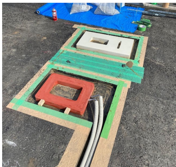
図 62. 超小型コイルの埋設の状況
