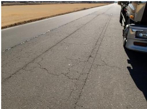
図 4.4 300～400m 地点(施工目地部のひび割れ)
