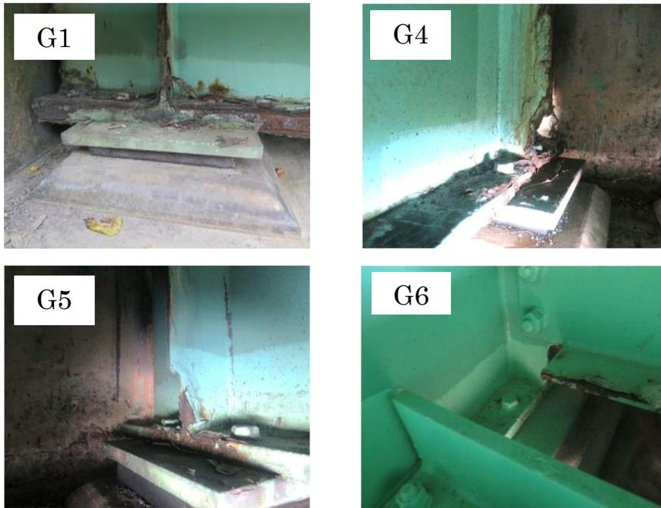
図 3.4.1 施工対象桁の腐食状況の例
