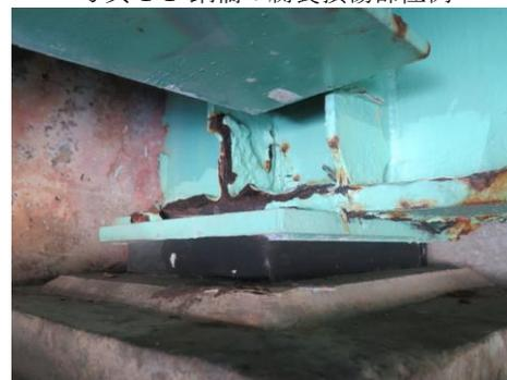
写真 1-2 鋼橋の腐食再劣化例
