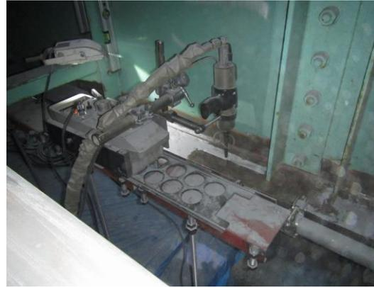
写真 3.6.2 半自動化施工装置を用いた CS 施工
