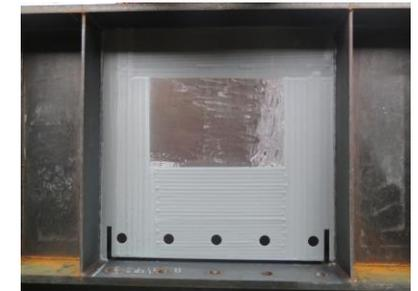
(d) Cold Spray 工法状況(炭素繊維接着工法)
