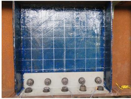
写真 4-5 当て板ボルト・炭素繊維接着工法
