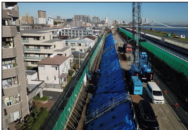
▲東砂六丁目高潮堤防耐震工事 工事状況（東京都江東区）
