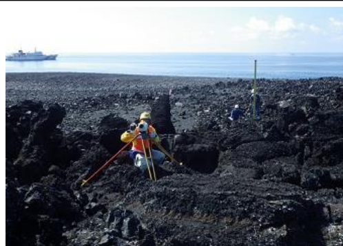
西之島における測量作業（三角点設置）
