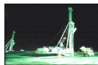
地盤改良を行い滑走路等の基本施設の陥没を防止
