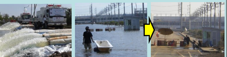
【排水前（11/23）】 【排水後（11/26）】
