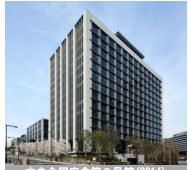
中央合同庁舎第8号館 (2014)
