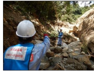
被災溪流調査
