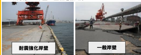
東日本大震災における耐震強化岸壁と一般岸壁の被災状況(小名浜港)
