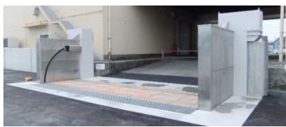
「津波による浮力で閉鎖」する陸閘(徳島県・撫養港)
