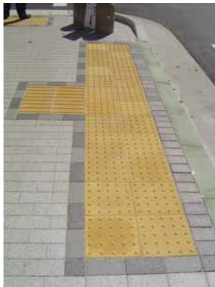
ICタグ付き誘導ブロック
