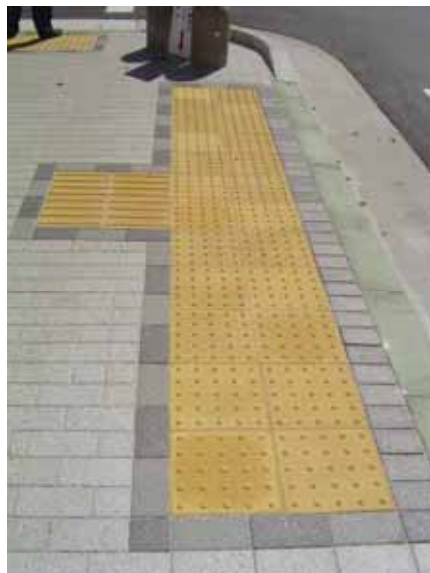
ICタグ付き誘導ブロック
