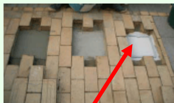
舗装下にICタグを埋設
