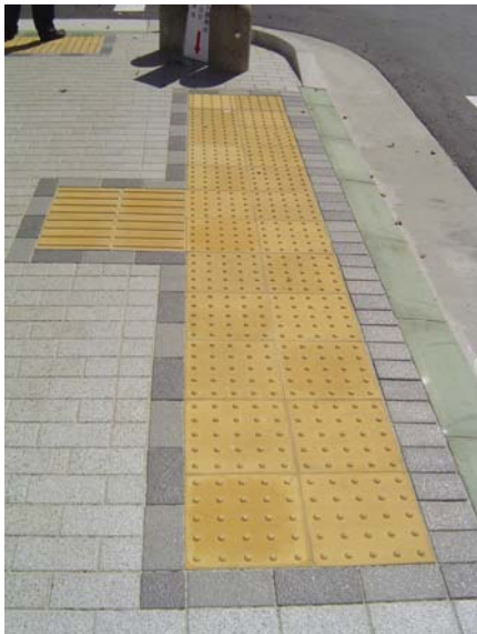
ICタグ付き誘導用ブロック
