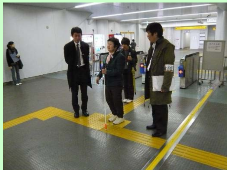
往路：ICタグ入り誘導ブロックと 専用白杖による情報提供
