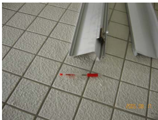
図 3.3.18 脱落したアルミ製回り縁
