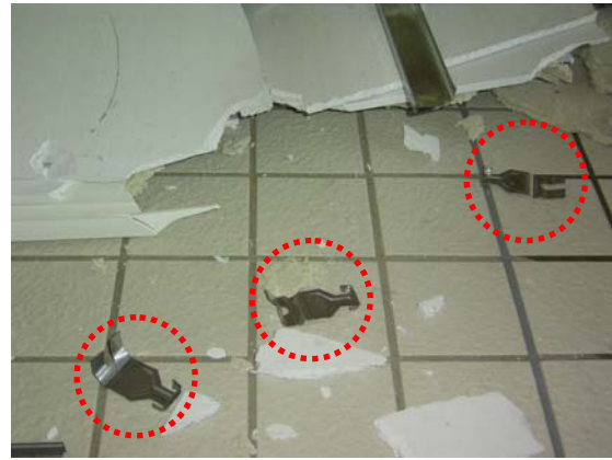
図 4.2.2 落下したクリップ
