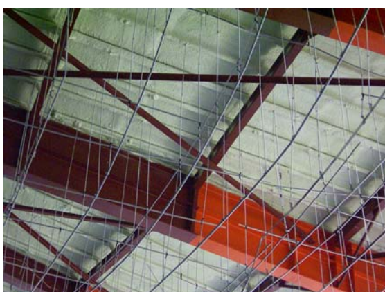
図 3.3.6 母屋と吊りボルトの様子
