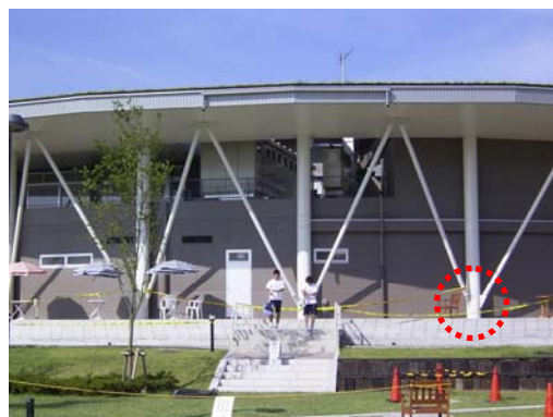
図3.1.2 建築物外観近景(赤丸部分が露出型柱脚)
