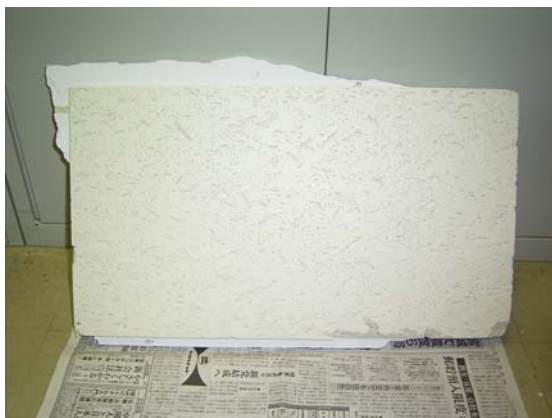
付録図 2.1 落下した天井面材の一部
