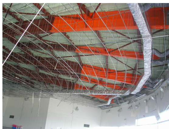
図 3.3.11 外周部から b 部方向を見る
