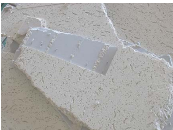
図 3.3.17 ロックウール吸音板の張付け状況
