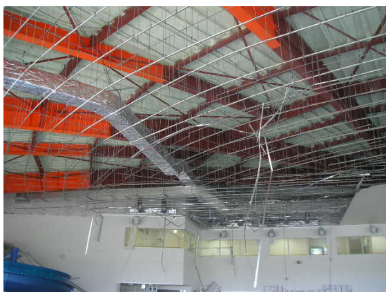
図 3.3.10 外周部から a 部方向を見る
