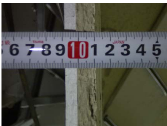
図 3.3.15 珪酸カルシウム板とロックウール吸音板
