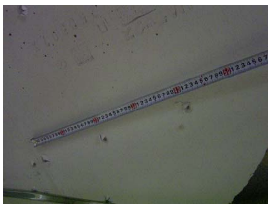
図 3.3.16 珪酸カルシウム板のビス止め跡
