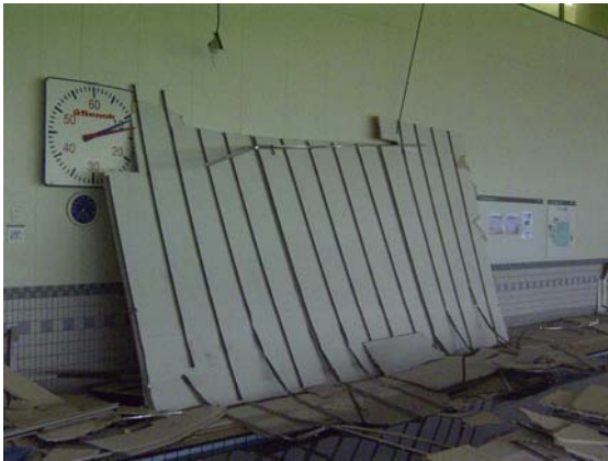
図 4.2.1 脱落した天井面
