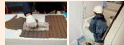
< 外断熱改修の施工風景 >
