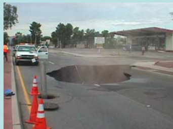
アリゾナ州タクソンにおける道路陥没(2002年9月) ※2箇所が発生
