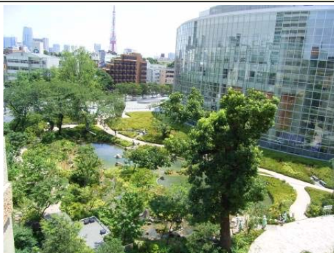
約 18,000\text{m}^2 の緑地を創出した六本木六丁目 第一種市街地再開発事業(東京都港区)
