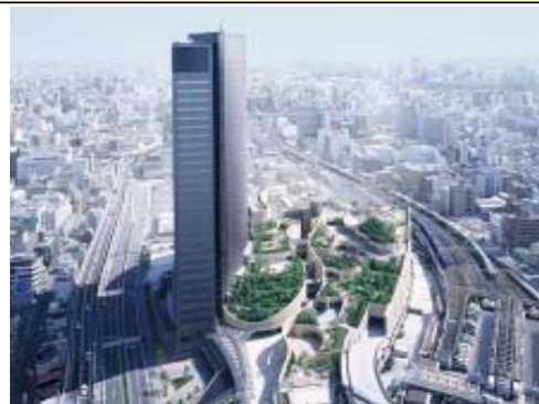
約 7,600\text{m}^2 の緑地を創出したなんばパークス (大阪府大阪市)
