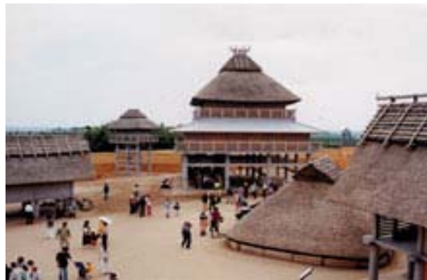
土舗装による北内郭内の広場
