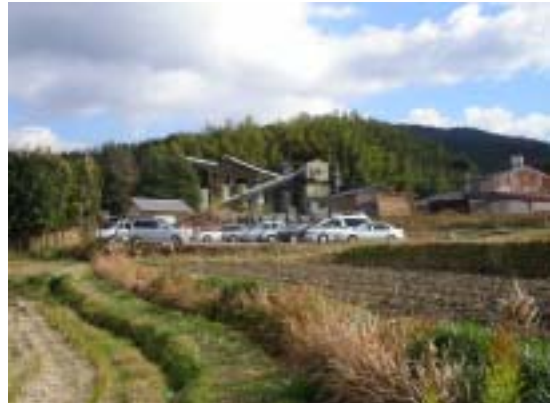
コンクリートプラント
