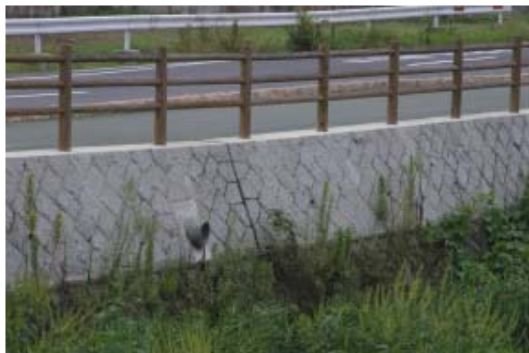
写真 8 - 10 飛鳥川護岸の一例
