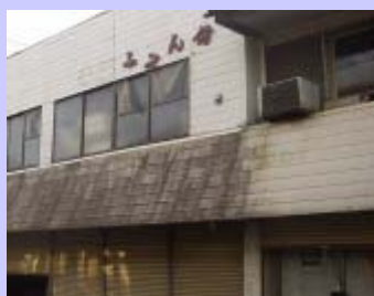
町家の全面を覆う看板
