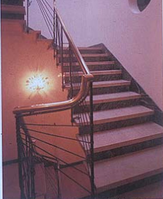
In order to make the most effective use of the site the stairwell was placed centrally and is lit by a skylight. 階段も物置よく使うための中央に置かれた階段室もトップライトで明るく照らしている。
