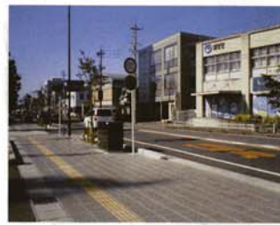
▲整備後の犬山大橋線
