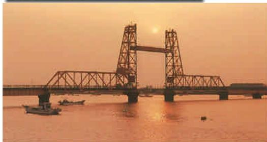
佐賀県諸富町と福岡県大川市の間を流れる筑後川に架かる昇開橋は、昭和10年5月に旧国鉄佐賀線の鉄橋として開通した我が国最大級の鉄道用可動橋である。この可動橋は、全長506m、中心部が高さ30mの二つの鉄塔に沿って23mの高さまでエレベーターのように昇り、開通当時は東洋一の昇開橋だった。しかし、昭和62年3月、佐賀線の廃止とともに鉄道としての役目を静かに終え、現在は、遊歩道の一部として再び活用されている。
