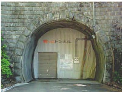
新山伏トンネルの完成によって役目を終えた旧山伏トンネルが、雪を利用しての農産物貯蔵施設として平成13年に生まれ変わりました。今まで厄介者であった雪と夏期の冷涼な気象条件、使用されなくなった旧山伏トンネルの断熱性の高い環境を活用し、雪を冷熱源とする低温貯蔵施設にトンネル内部を改造し、地元農産物の低コストでの長期貯蔵を実現するものです。
