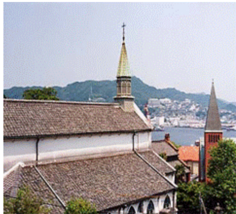
長崎市南山手伝統的建造物群保存地区(長崎県)
