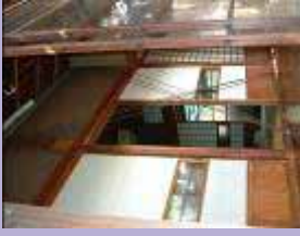
耐震補強工事の一例
