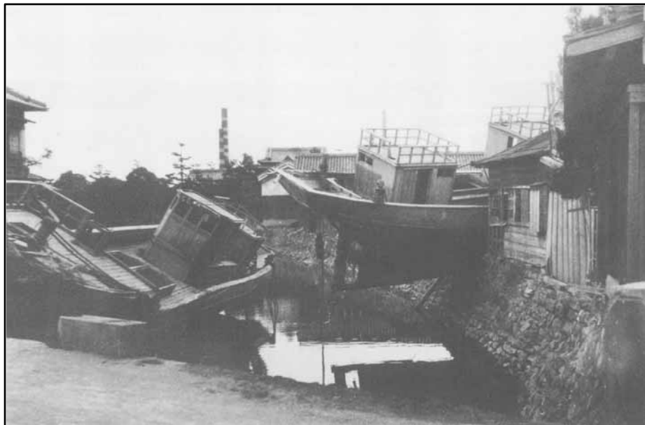
津波により民家に突き刺さる漁船(和歌山県海南市)
