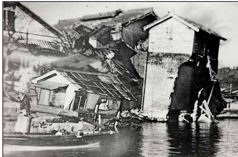
津波により被害を受けた家屋(高知県須崎港)
