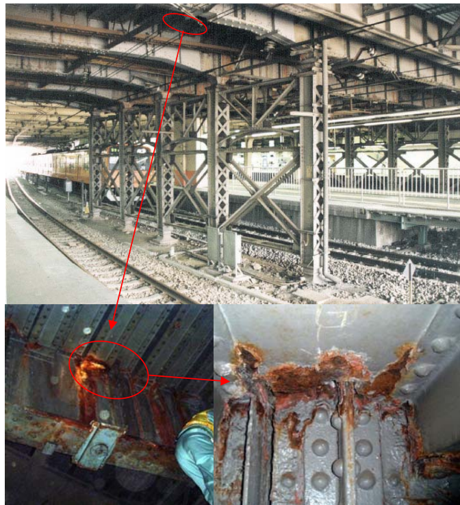
※新宿駅南口地区基盤整備事業の一環として、架替工事中
