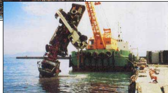
港内へ転落した車両の引き上げ作業 (北海道奥尻港)
