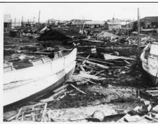
津波による瓦礫の山（北海道霧多布港）
