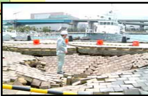
中央ふ頭 岸壁(-7.5m) (イベントバス)
