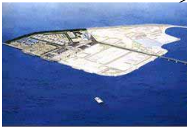
下関港・多目的国際ターミナル
