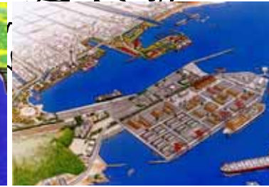
敦賀港・多目的国際ターミナル
