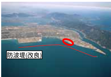
境港・多目的国際ターミナル
