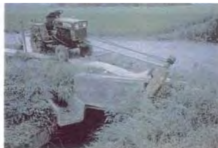
仮設揚水ポンプの設置②（トラクタの動力を利用） 用排水路が分離されている地域においては、排水路に各種の動力源による揚水ポンプを設置して水の反復利用を図った。
