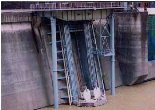
選択取水設備設置状況
