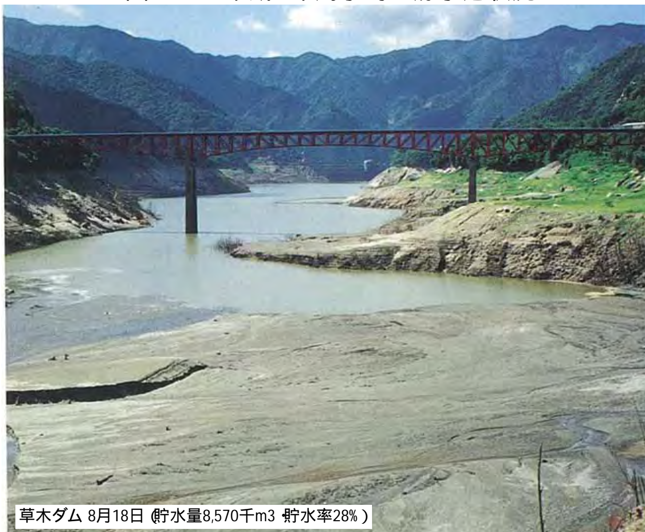
図 9 - 1 平成 6年渇水時の貯水池状況
