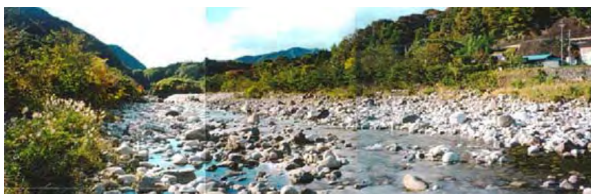
整備後（0.3m 3 /s 放流）：同地点 無水状態が回復
