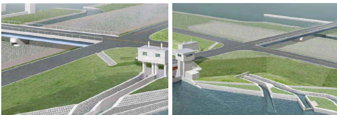
常陸川水門魚道の完成予想図（水門右岸下流側、上流側）
