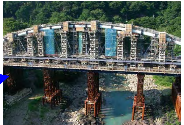
JR付替工事（第三吾妻橋梁）
