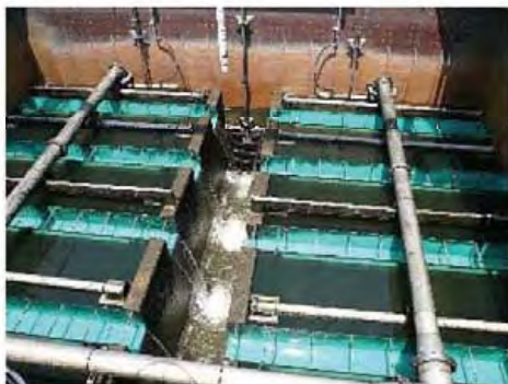
急速ろ過池の内部
