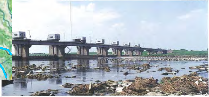
利根大堰地点 平成6年8月5日
