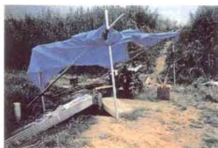
仮設揚水ポンプの設置①（耕耘機の動力を利用） 用排水路が分離されている地域においては、排水路に各種の動力源による揚水ポンプを設置して水の反復利用を図った。
