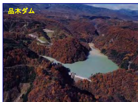
ダム湖で中和反応の促進と中和生成物の収容を行う
