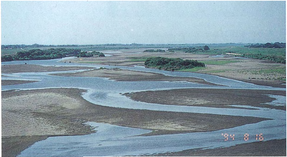
埼玉大橋地点 平成6年8月16日(利根川俣地点流量 14m 3 /s)
