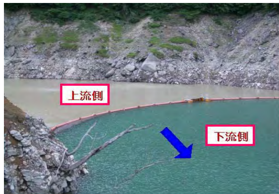
濁水拡散防止フェンスの設置状況 (H16.6)
