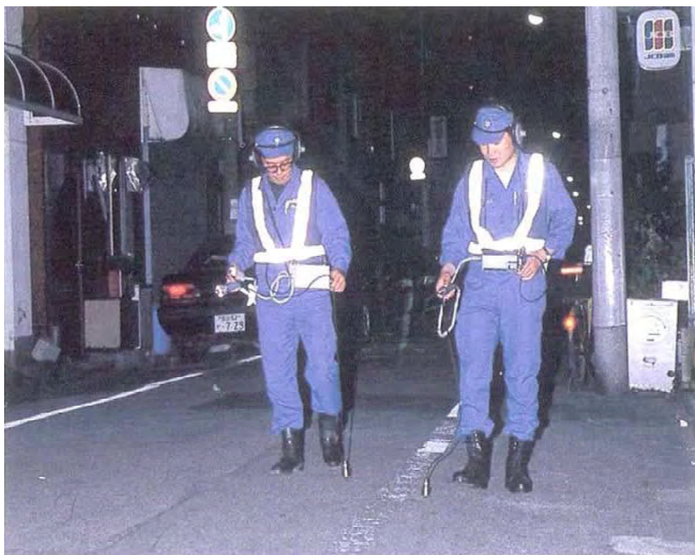
写真 夜間の漏水点検作業
