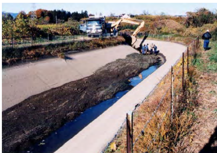
写真 舗装開水路 断水しての堆積土砂の除去
