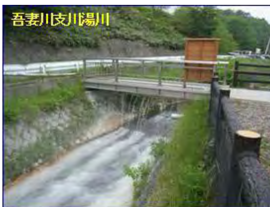
調整された石灰ミルクを湯川に投入
