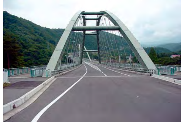
付替国道工事（長野原めがね橋）
