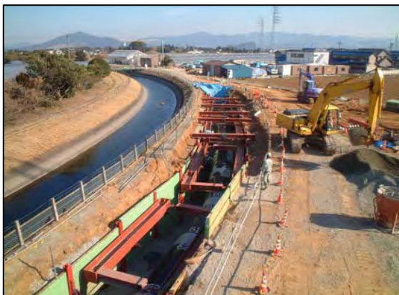
工事中の併設水路
