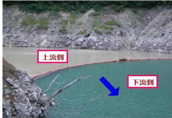
濁水拡散防止フェンスの設置状況(H16.6)
