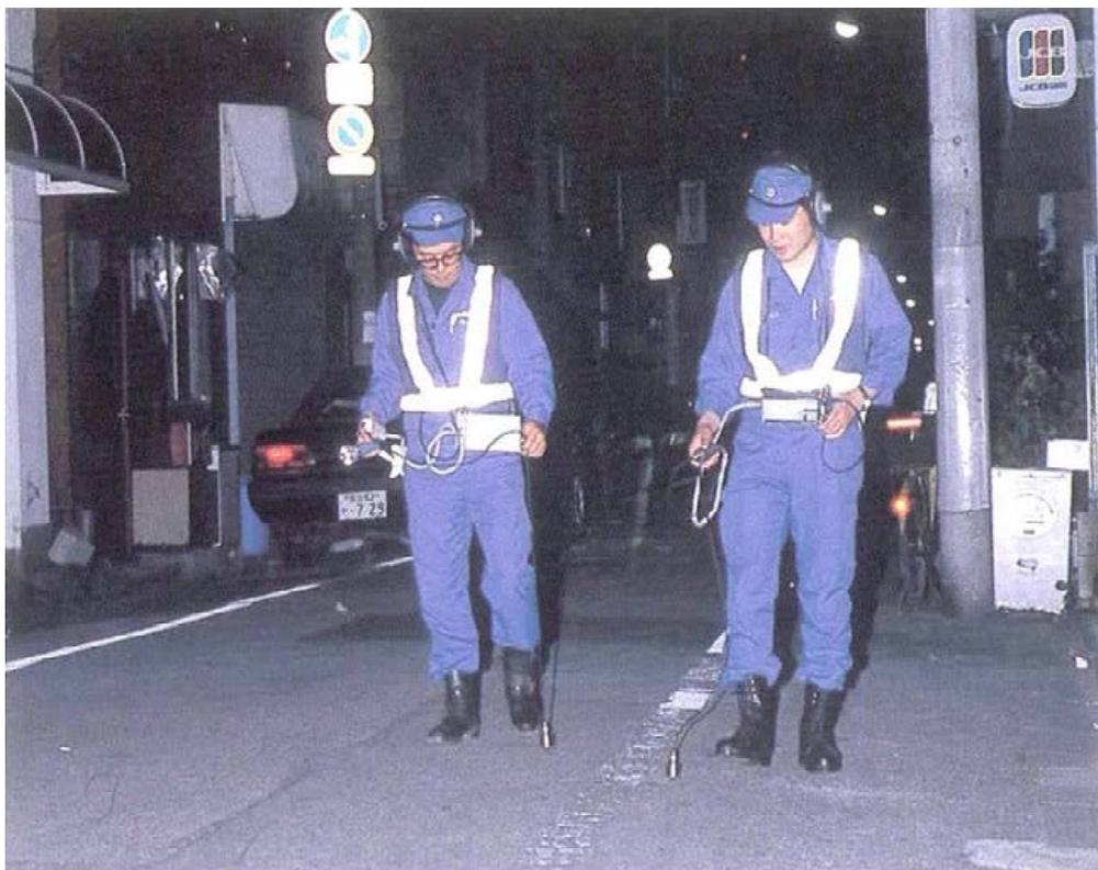
写真 夜間の漏水点検作業
