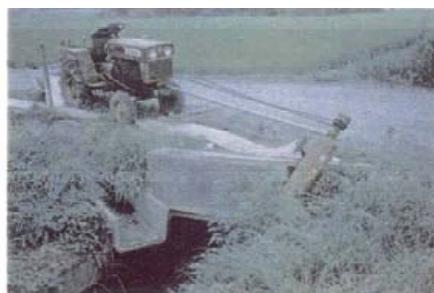
仮設揚水ポンプの設置②（トラクタの動力を利用）
