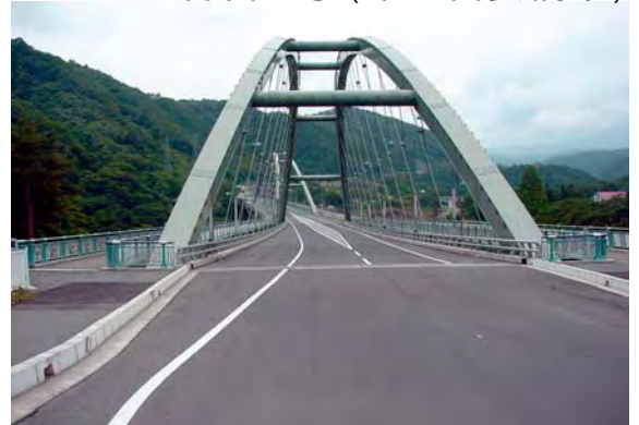
付替国道工事 (長野原めがね橋)
