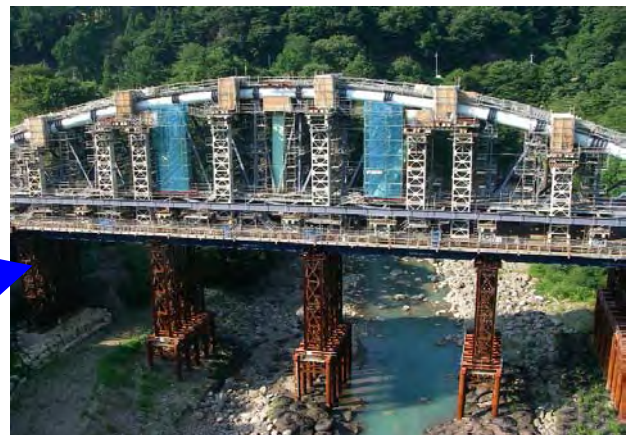
JR付替工事 (第三吾妻橋梁)
