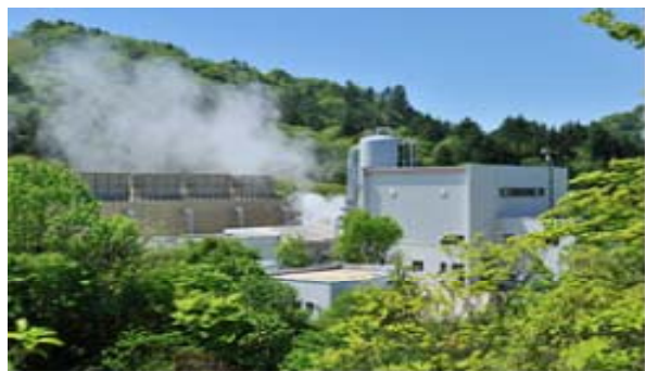
(写真: 鬼首地熱発電所【電源開発(株)HPより】)
