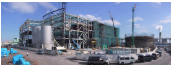
川崎市ゼロエミッション工業団地工事状況
