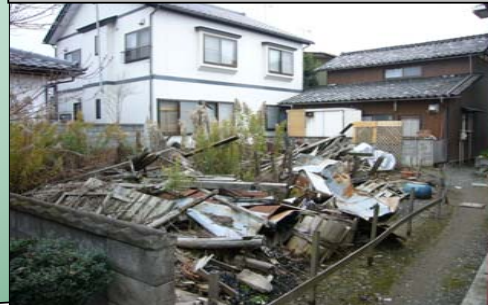
廃材が放置されている宅地
